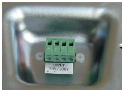
Рис. 5. Подсоединение и закрепление акустического кабеля
